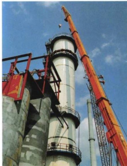
Montage des Dachs des neuen Stahlzuckersilos in dem Werk Regensburg.
