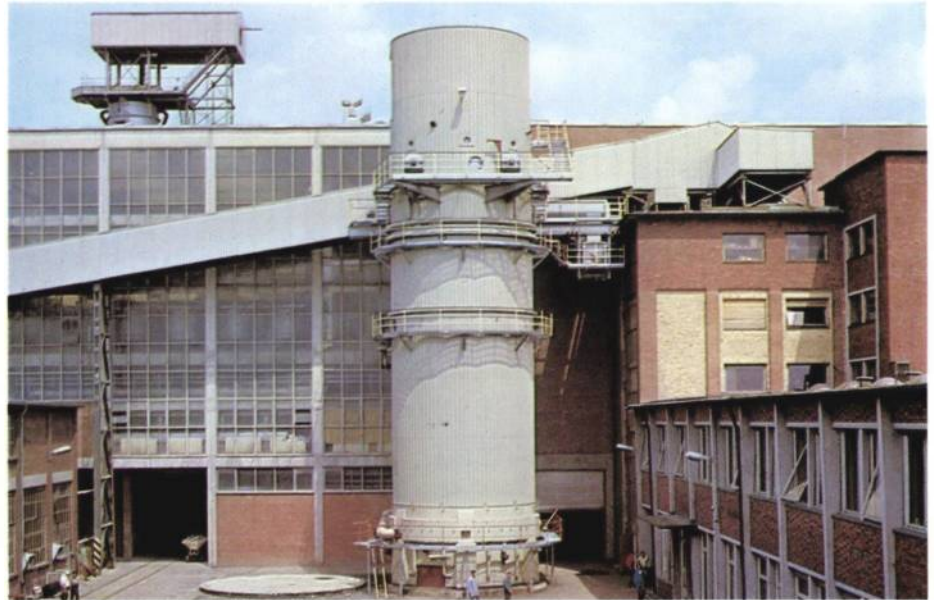
Extraktionsanlage im Werk Groß-Gerau.
