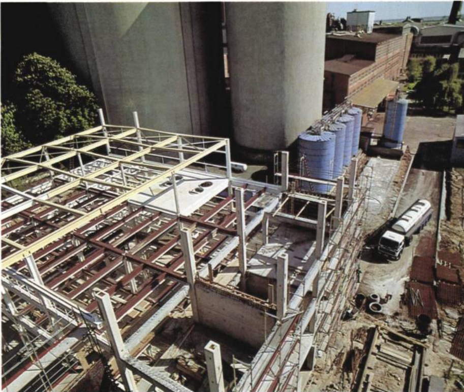
Rohbau der Fruchtzuckeranlage im Werk Offstein.
