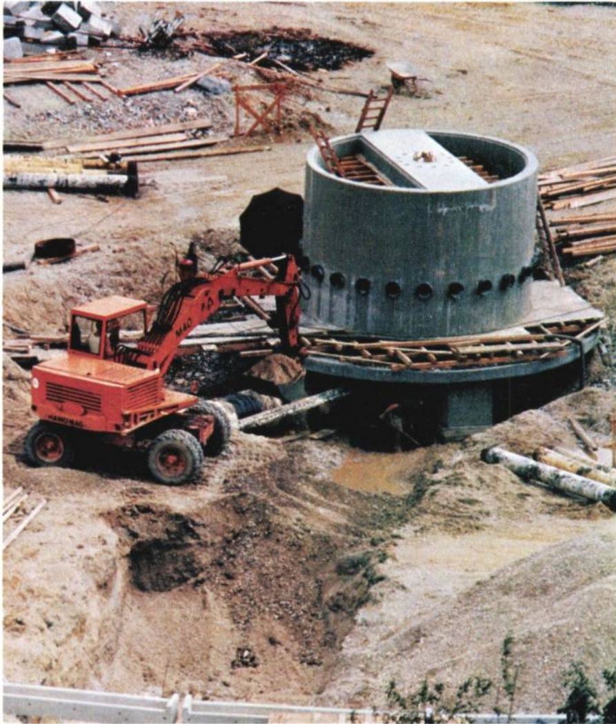
Bau einer Schwemmwasserkläranlage △
