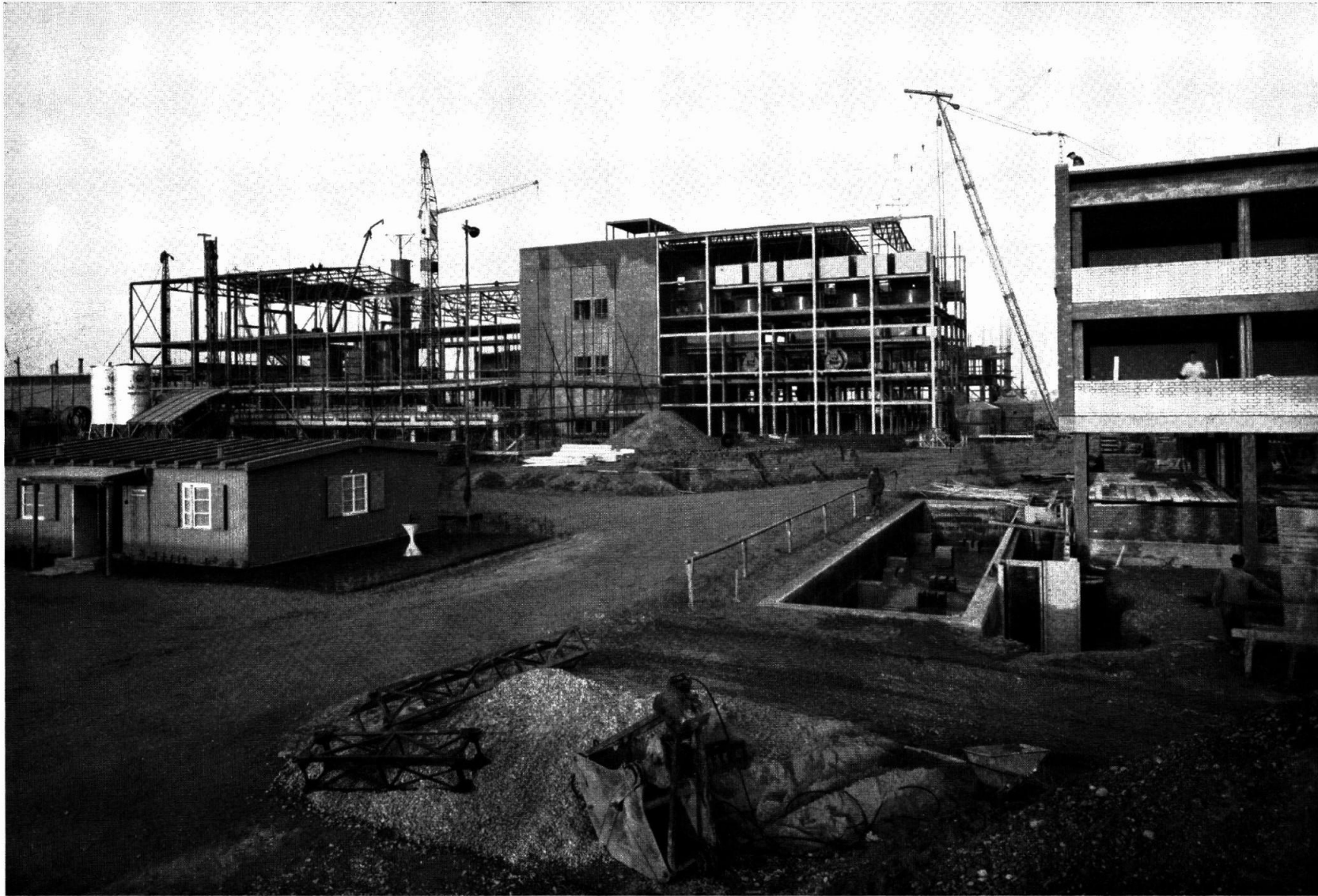
Neubau des Werkes Rain (September 1956)
