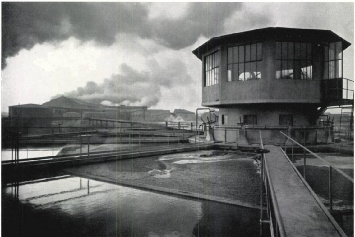
Südzucker-Fabrik Regensburg: Borsig-Kläranlage für Schwemmwasser
