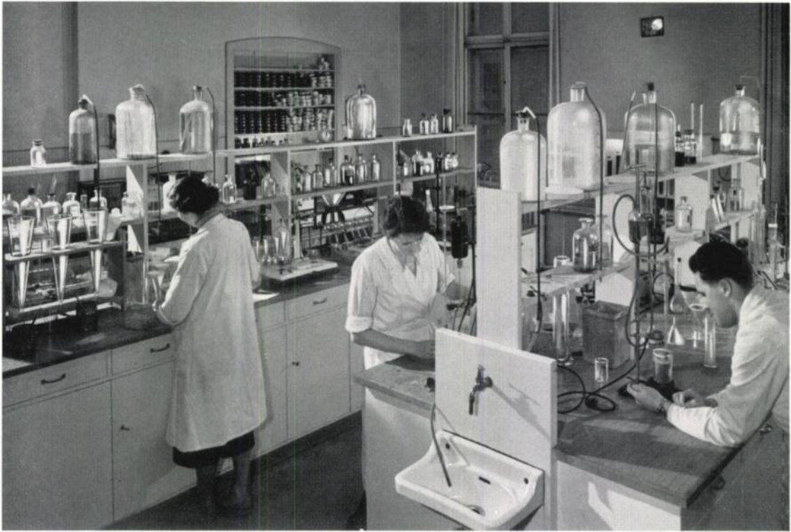
Südzucker-Fabrik Regensburg: Laboratorium
